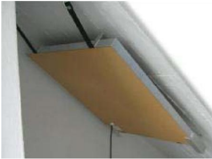
Bild 4 Montage an Dachschrägen
